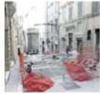
La fase uno dei lavori
